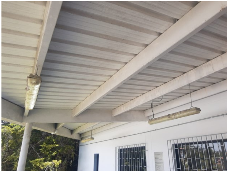
Ilustración 33 Falta de pintura de la cubierta metálica y luminarias sede principal
