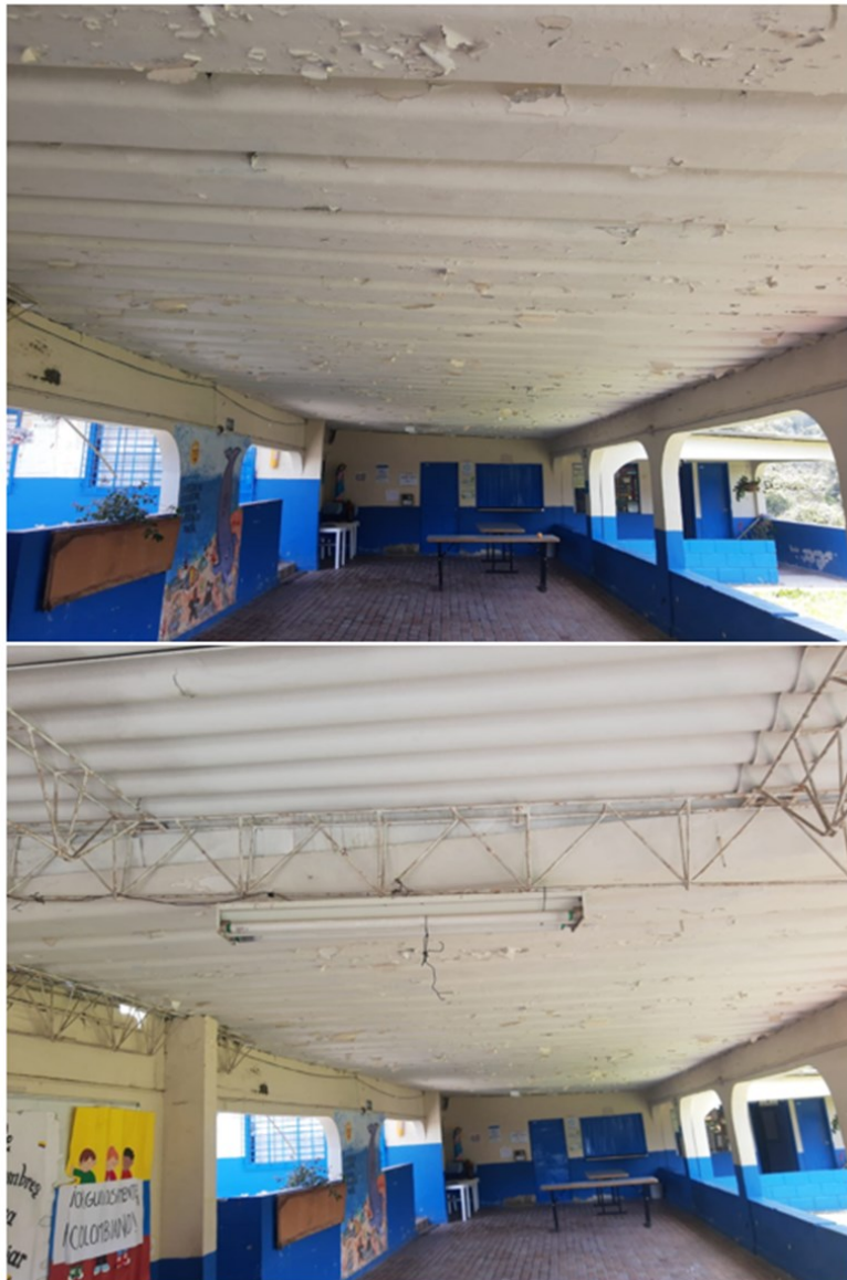
Ilustración 34 Deterioro de pintura y luminarias Sede Gonzalo Aristizábal
