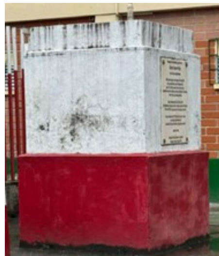
Ilustración 25 Humedades al interior y exterior de la Institución
