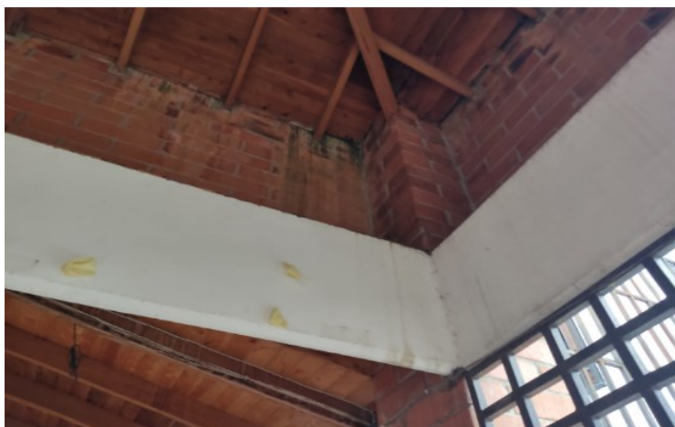
Ilustración 23 Evidencias Goteras
