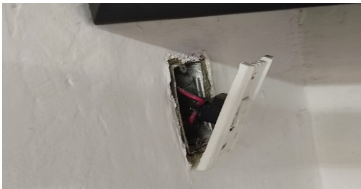
Ilustración 22 Deficiencias en puntos eléctricos
