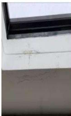
Detalle filtración humedad claraboyas y fisuramiento de muros Fuente: Registro Fotográfico Auditoría (02/06/2020) Elaboró: Juan Camilo Gómez Berrío, CA
