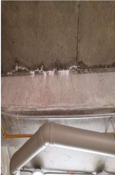
Filtraciones en losa Evidencias equipo auditor
