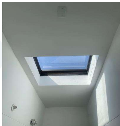
Se realizó el arreglo con sello por exterior de la claraboya.
